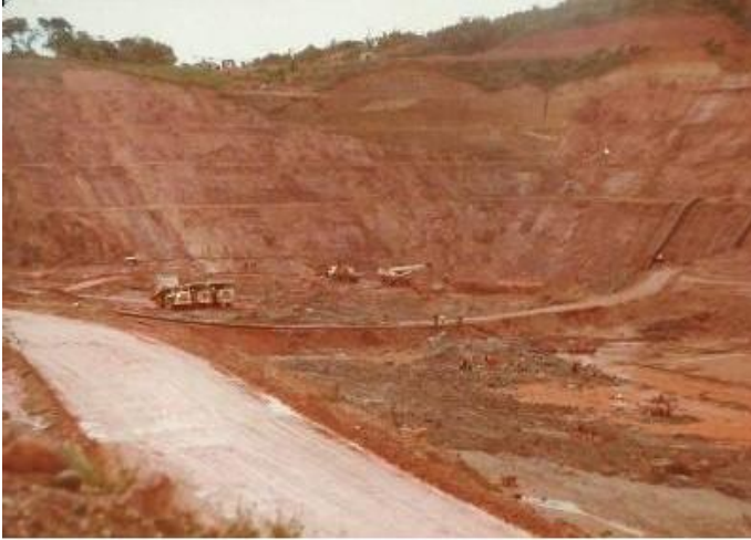
Cantiere Betania - Diga a monte
