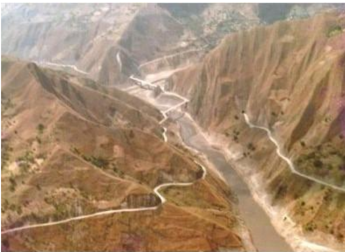
Strada a Guateque, zona dell'incidente
