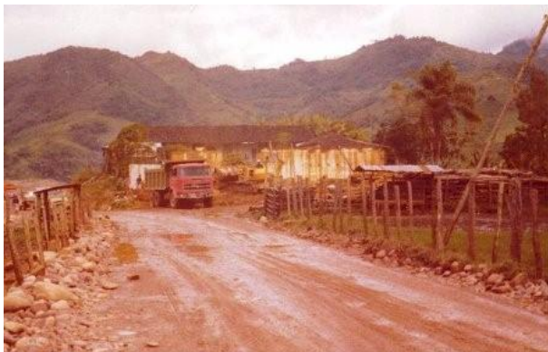
Fabbricati in demolizione per dare spazio alla piazza, case scapoli, mensa e club.
