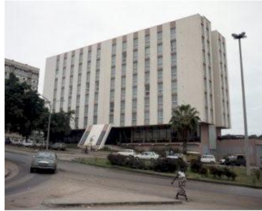
L'edificio ormai in via di ultimazione
