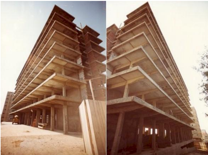
Lo stato dell'edificio da ultimare
